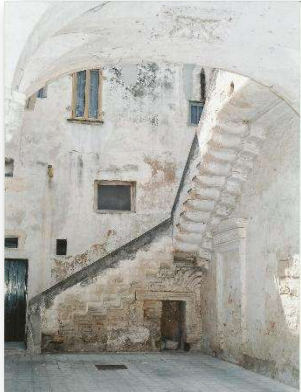
Scala di accesso al piano nobile
